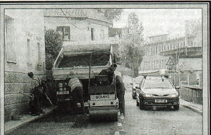
Kranj, 29. septembra - Savska cesta od križišča pod Mohorjevim klancem proti stavbi nekdanje klavnice je bila nekaj dni ozko prometno grlo, ki se je s svežim asfaltom torej ponovno sprostil. Delavci kranjske Komune so po naročilu iz mestne občine odstranili bolj ali manj posedene granitne kocke, v katerih so se nabirale velike luže, na novo utrdili spodnji ustroj in položili asfalt. Podobne prenovne sta bili sredi poletja deležni že Poštna ulica z delom Glavnega trga v mestu, če bodo v občinski blagajni našli še kakšen tolar, pa naj bi letos z ravnim asfaltom prekrili tudi najbolj kotanjast del Koroške ceste. • H. J., foto: T. Dokl
