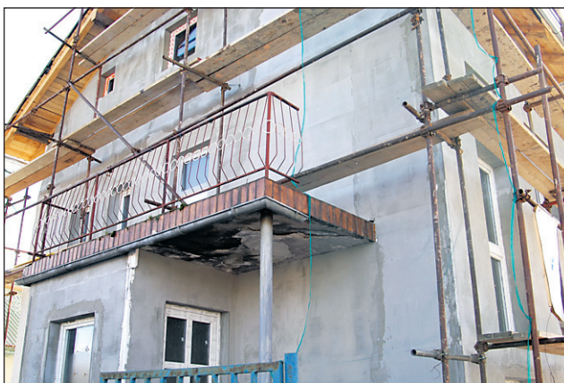
Hišo na Mariborski cesti, v kateri se je zgodila usodna eksplozija, so že obnovili in te dni dobiva novo fasado.
