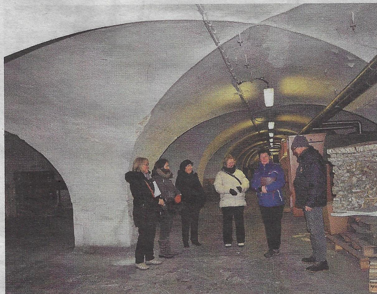
Enoprostorske etaže so s slopi razdeljene na dve obokani ladji.
