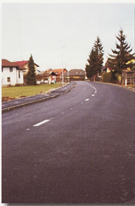
Obnovljeno cestišče s pločniki in razsvetljavo skozi Moškanjce
