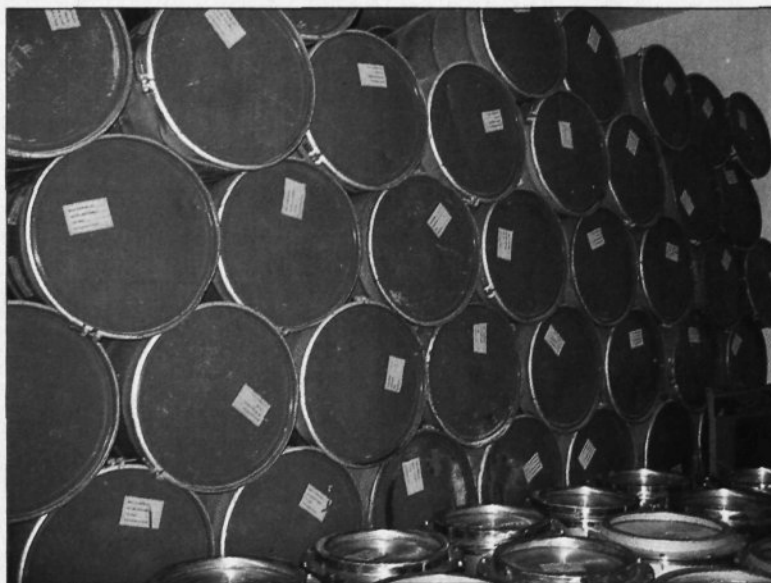
V skladišču Nuklearne elektrarne Krško trenutno shranjujejo nekaj več kot 2250 m 3 nizko in srednje radioaktivnih odpadkov. Lokacijo za končno odlagališče zanje moramo v Sloveniji izbrati do leta 2008, zgraditi pa ga moramo do leta 2013.
