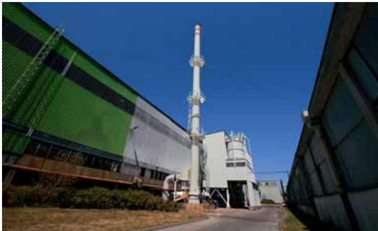
Čistilna napravi na peči za pečenje anod
