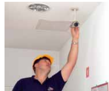
Varnostni tehnik pri nameščanju nadzorne kamere
