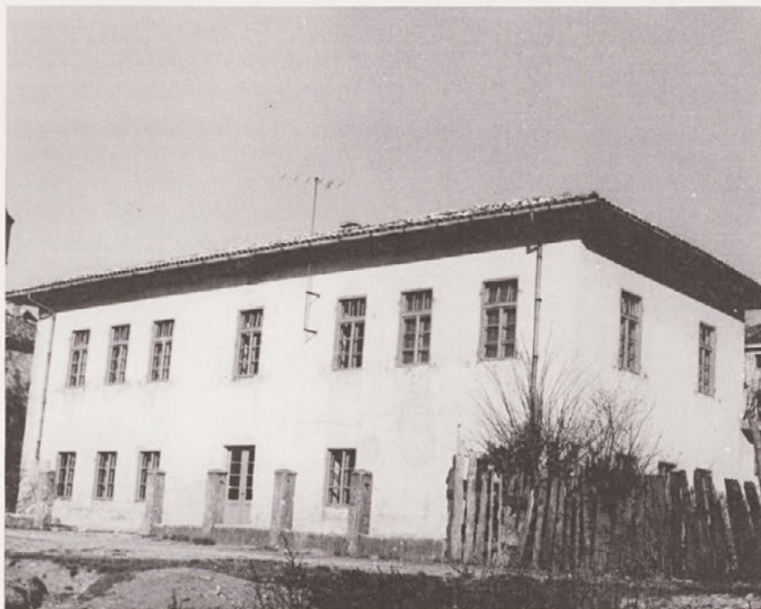
Južna fasada šole, preden se je začelo urejanje igrišča za asfaltacijo. Tik ob poti proti pokopališču je bil 0,5m visok zid s stebri. Desno spredaj je ograja vrta Puc Edota in znamenita bezga, ki bi znala marsikaj povedati.
