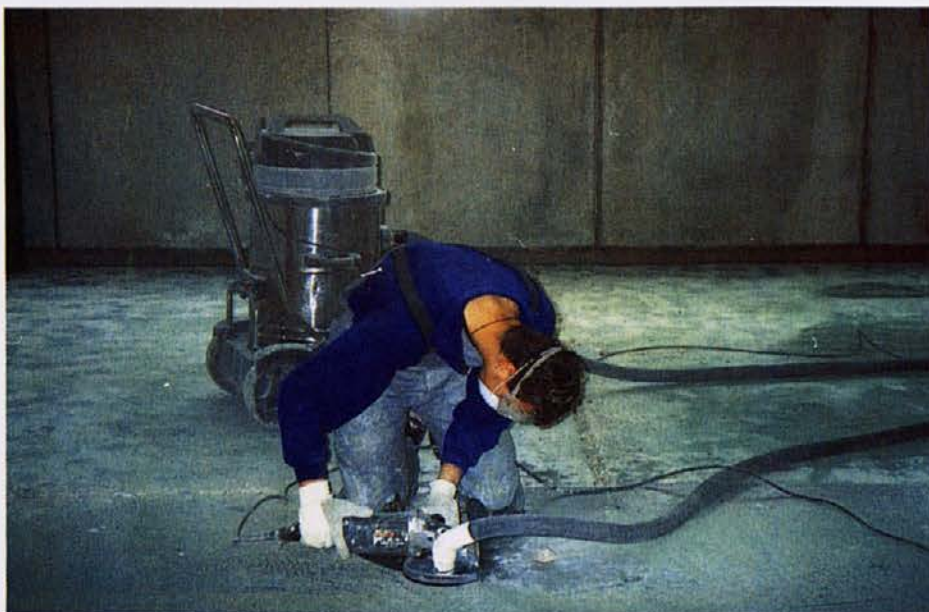
Brušenje tlakov pred nanosom novega sloja
