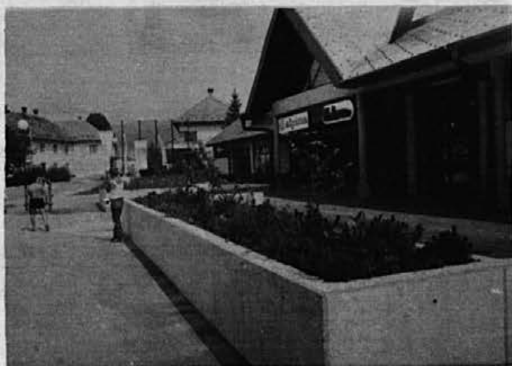
Zadrega z vzdrževanjem blagovnice
