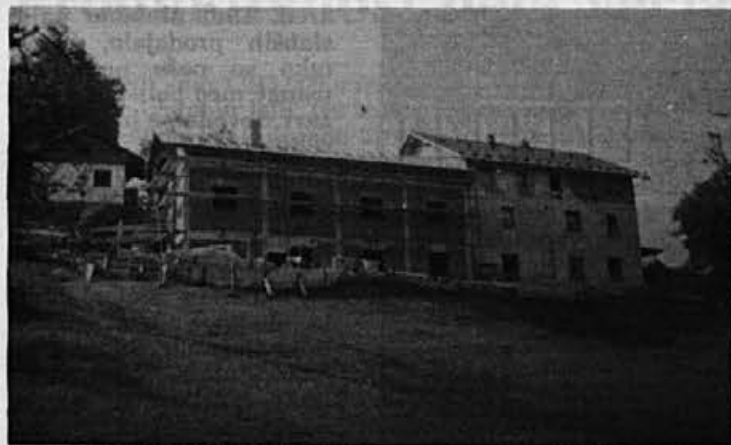
Dograditev in obnova obrata v Rovtah poteka po načrtih
