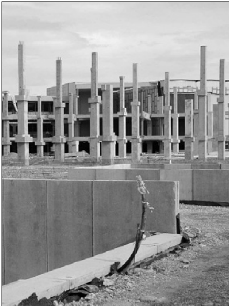
Gradbišče ob Ikeini trgovini v Vilešu
