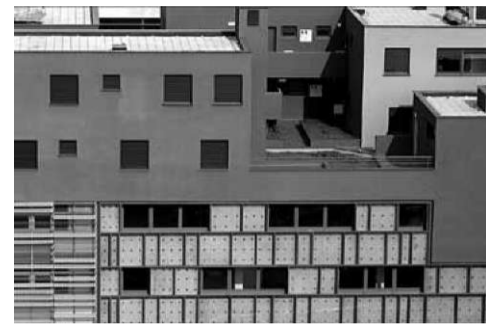
Stanovanjsko poslovni kompleks Zagrad, Reka, 2007, streha. Zagrad Centre, Rijeka, 2007, the roof.
