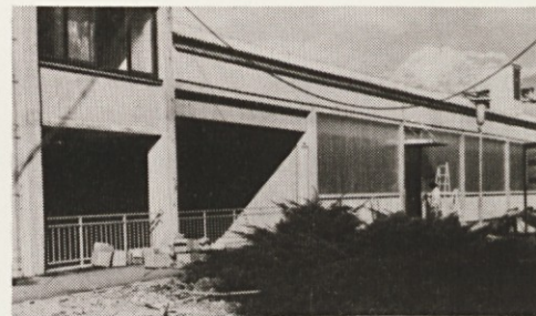
... pred 15 leti: nova hala šivalnice, skladiščnih in komercialnih prostorov je gotova
