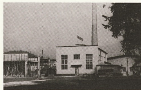
Kotlovnica, prvi zgrajeni objekt na Perovem, v ozadju barvarna in pričetek gradnje tkalnice frotirja
