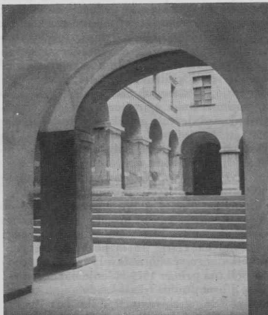
Splošni pogled na obnovljeno dvorišče in dvoriščne arkade na današnjem Mestnem trgu št. 27, sezidane l. 1659 za mrčune soli
