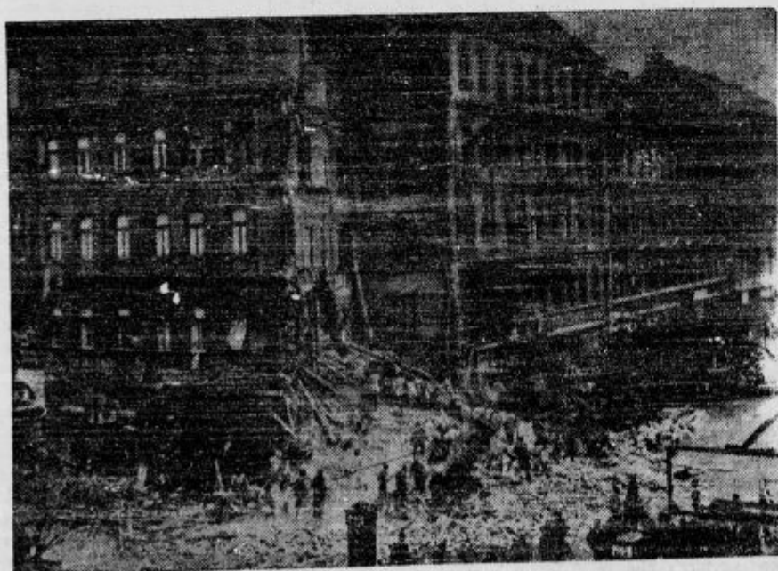
V Budimpešti se je pred nekaj dnevi porušila štirinadstropna hiša. Pod ruševinami je našlo smrt štirideset ljudi.
