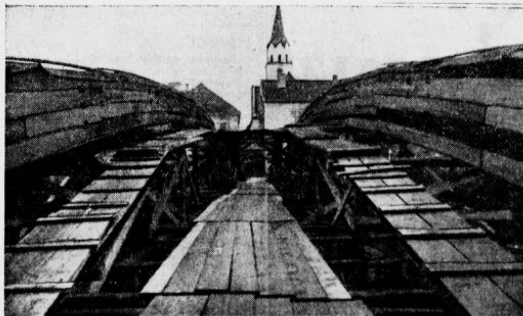
Močni leseni nosilci (desno in levo) novega mosta čez Kokro
