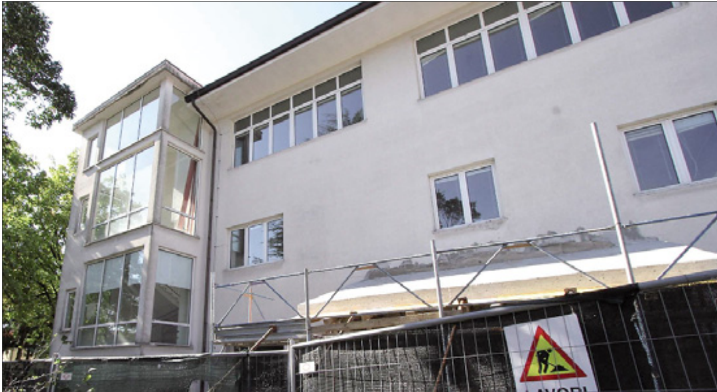
Gradbena dela na poslopju nižje srednje šole v Doberdobu
