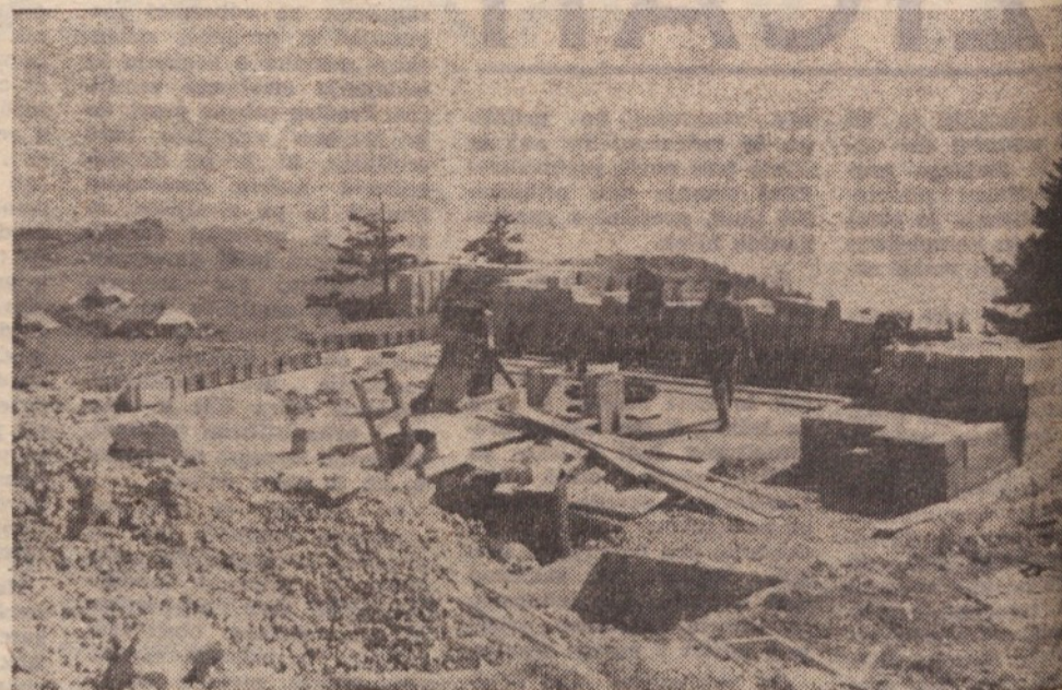
PRVA PLOŠČA ZGRAJENA — Črnuški planinci so letos zabetonirali prvo ploščo svojega doma na Mali planini. Pripravili so tudi 2.500 zidakov. Prostovoljnih delovnih ur se je nabralo že toliko, da jih menda že ne štejejo več.
