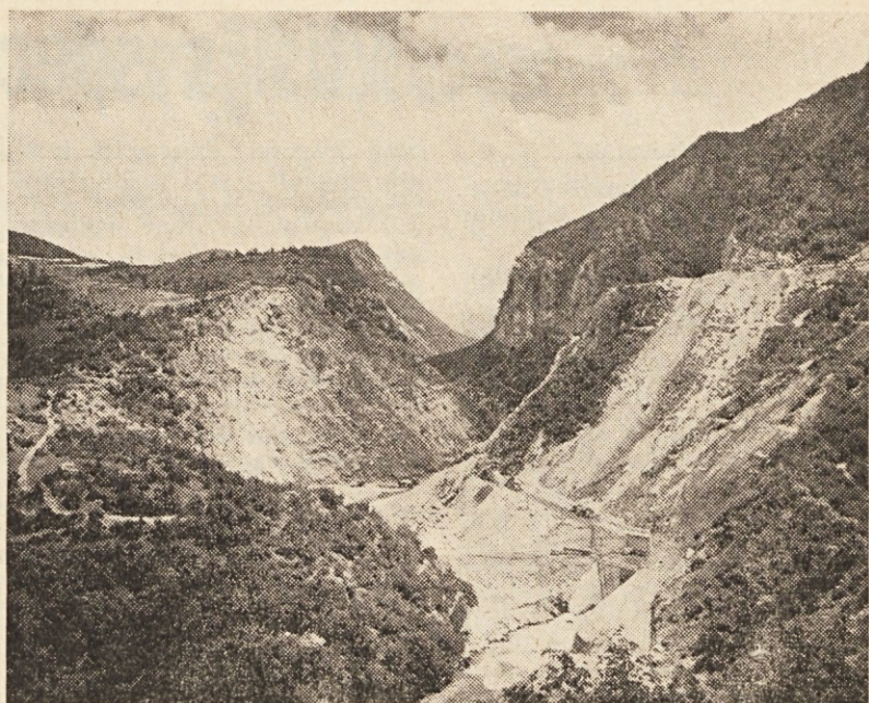
Kanjon Rame pri vhodu v strojnico
