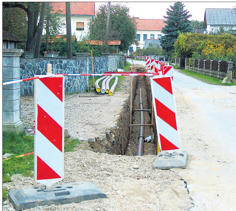
Prvi vodi kanalizacijskega sistema v Dornavi so že položeni.
