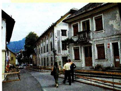
Potres je preskusil kakovost popotresne obnove in izvrševanje sprejetega popotresnega zakona.
