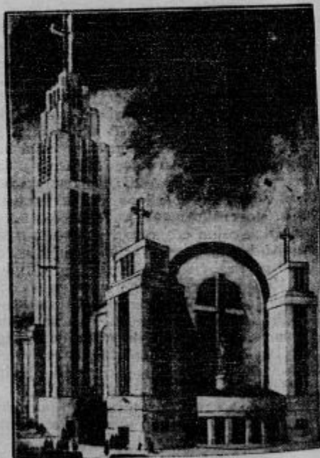
Prve jeklene cerkev na Danaju bodo v kratkem začeli graditi. Načrte je napravil avstrijski arhitekt Prutscher. Cerkev bo vsa iz jekla.
