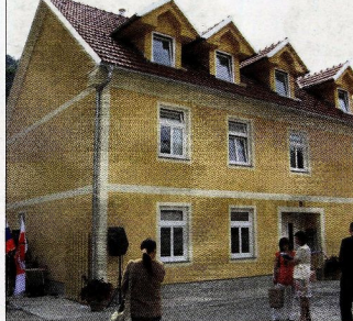
V turističnem Rogatcu dobiva zaščiten trško jedro vse urejenejšje goste. Nazadnje so obnovili staro hišo v Obrtniški ulici 1 (na fotografiji).
