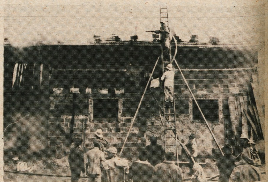
Med nevihto je v ponedeljek, 19. maja, popoldne strela udarila v gospodarsko poslopje Janeza Križnarja na Škofjeloški cesti v Kranju. Pogorelo je ostrešje hleva in senika s krmo in sušilno ter puhalno napravo, poškodovana pa je tudi stanovanjska hiša. Škode je za okoli 250.000 din. Pri gašenju so pomagali sosedje, gasilci iz Kranja in Strazišča.
