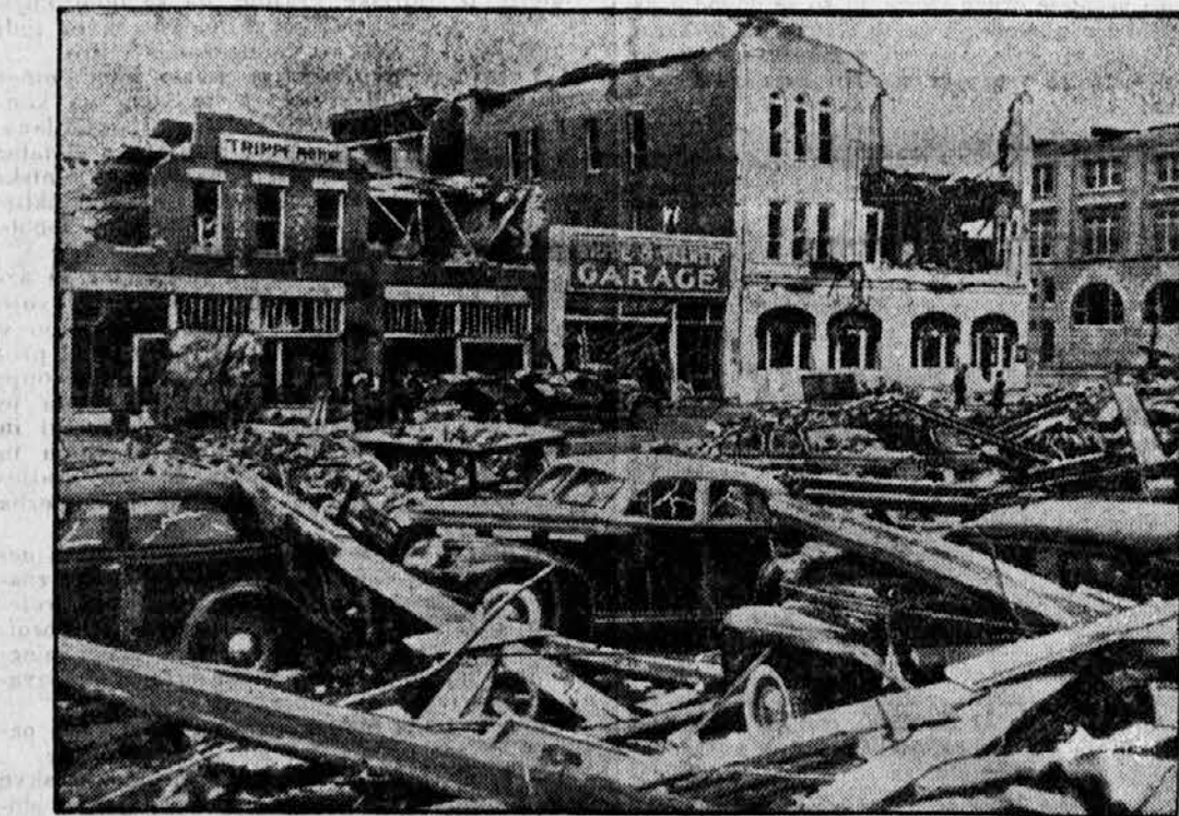
Tornado, ki je divjal po mestu Albany v državi Georgia (USA) je porušil tri sklade hiš v mestnem stanovanjskem delu in dvanajst skladov v trgovskem mestu. Mrtvih je bilo 27 oseb
