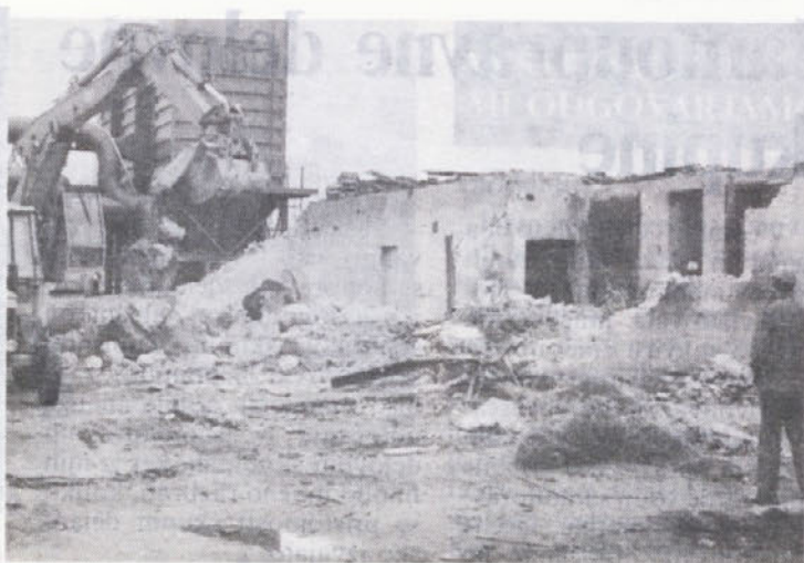
Podiranje stare kurilnice kjer bo stala nova in sodobna
