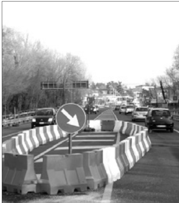
Vožnja po viaduktu je še vedno ovirana
