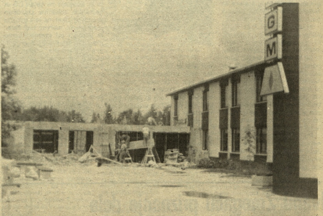
Prizidek upravne zgradbe in zaklonišče v Latkovi vasi
