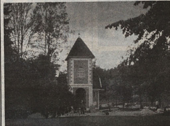
Zaključna dela na Sv. Valentinu
