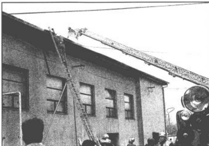
Prvo udarniško zgrajeno stavbo velenjskega kina je 5. aprila 1992 opustošil požar.
