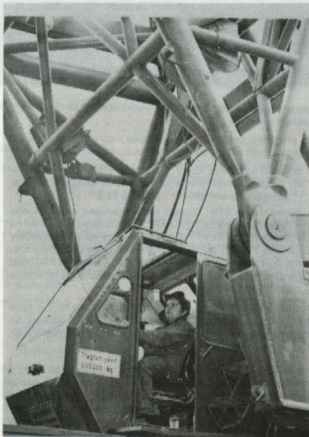
Z gradbišča TEŠ IV - Georg Grünig iz ZRN, vodja 600-tonskega žerjava za dela pri postavljanju kotelne konstrukcije
