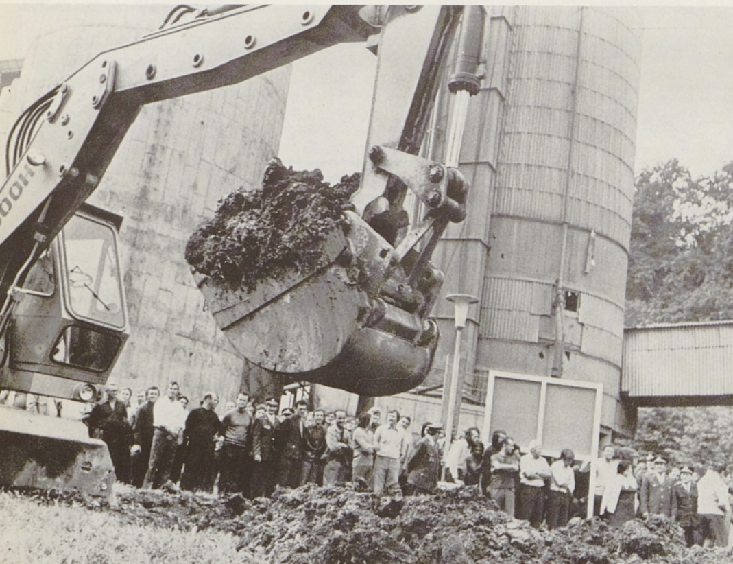
Ob začetku del graditve najvišjega dimnika v Evropi v Trbovljah, ki naj bi preprečil preveliko onesnaževanje zraka v tej kotlini
