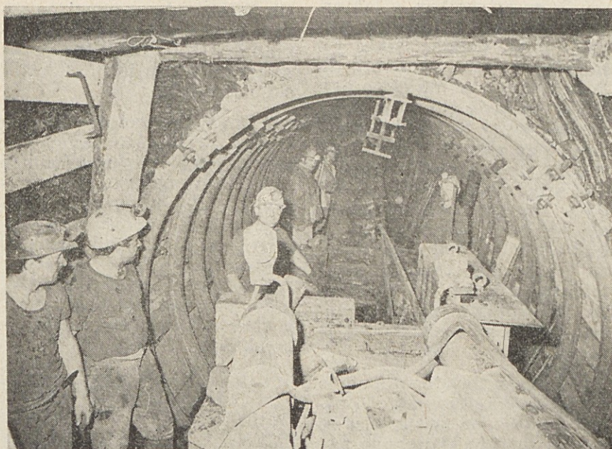
V jami Hrastnik je stroj za napredovanje prog F 6-A, izdelal mnogo prog in s tem vsaj deloma nadomestil težko delo rudarjev (Foto M. C.)
