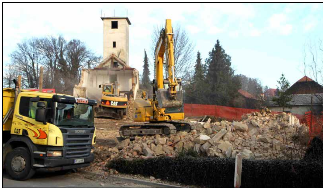
Rušenje objektov je opravilo podjetje Cizej, s. p., iz Prekope.
