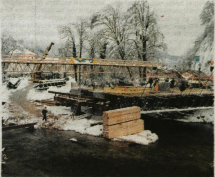
»Železni most« dejansko ostaja železni, saj bodo delavci v železobetonsko konstrukcijo vgradili preko sto ton železa.
