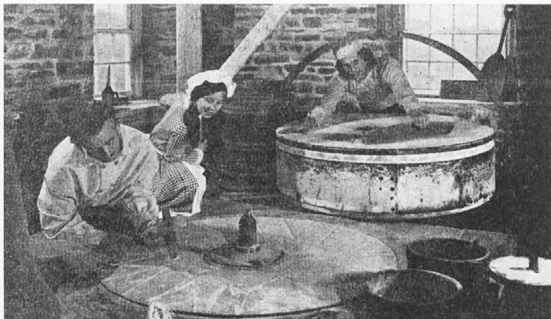
Zelo zamudno delo je ostrenje mlinjskih kamnov, ki zahteva potrpljenje. Eno izmed opravil v vasi ob Črnem potoku.
