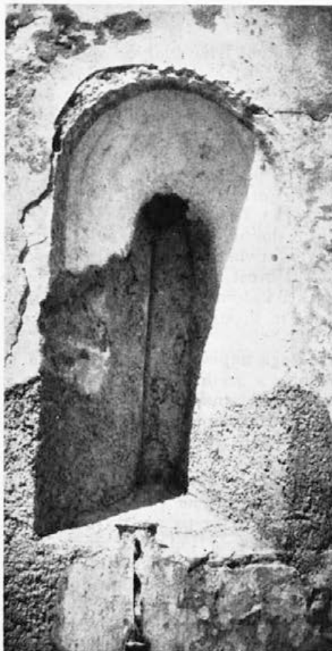
Sl. 80. Poljčane — rekonstruirano romansko okno po odstranitvi napisnega kamna
