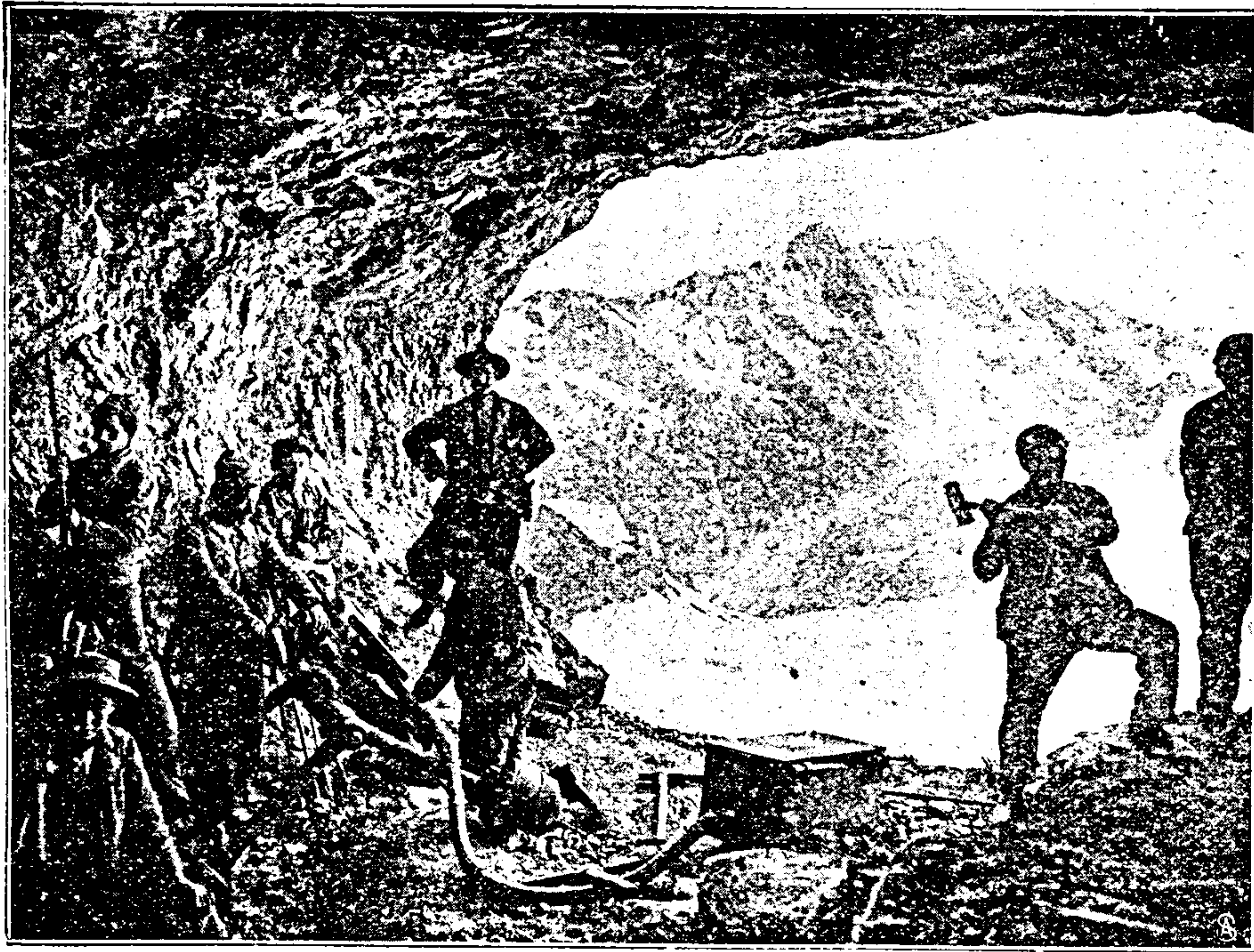
Der Tunnel bei der neuen Station Gismeer der Jungfraubahn.
