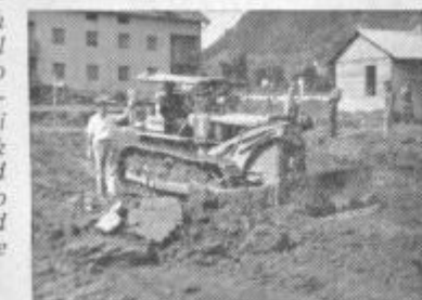
Gradnja stanovanjskega bloka zdravilišča
