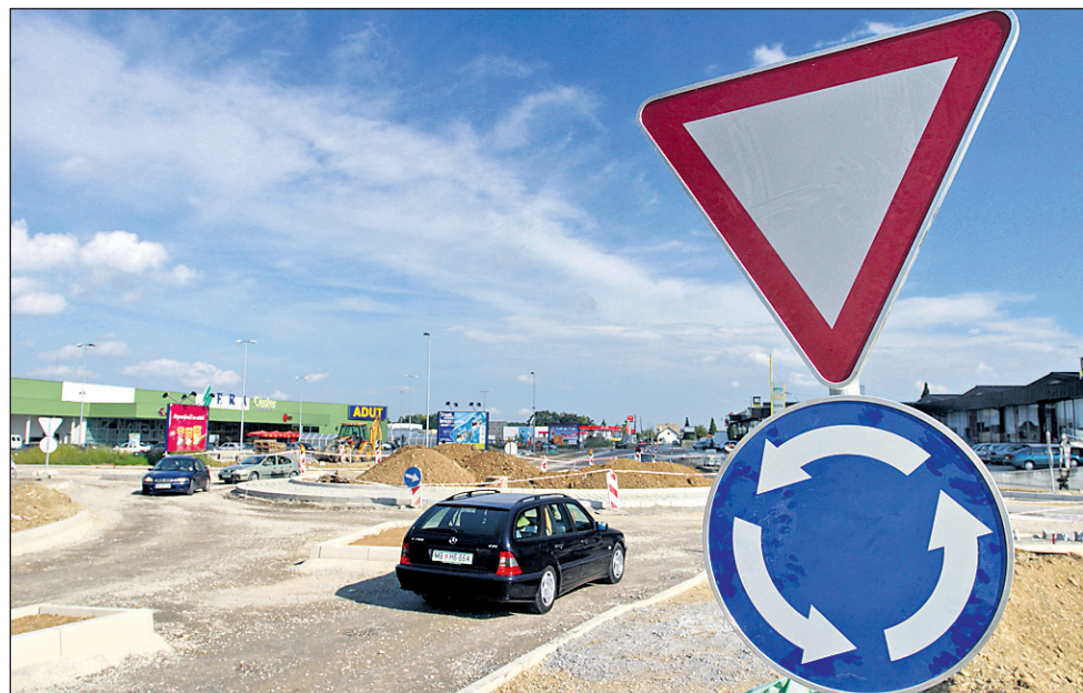
Foto: Črtomir Goznik Na Dornavski cesti zaključujejo gradnjo prvega ptujskega krožišča. Dela so v sklepni fazi.
