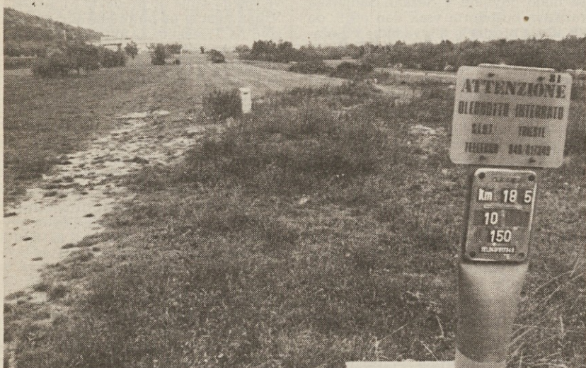
Novi plinovod bo tekkel vzdolž starega ob naftovodu
