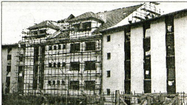
Gradbinec na Zlatem polju v Kranju gradi zavod za zdravstveno varstvo. Foto: Tina Dokl
