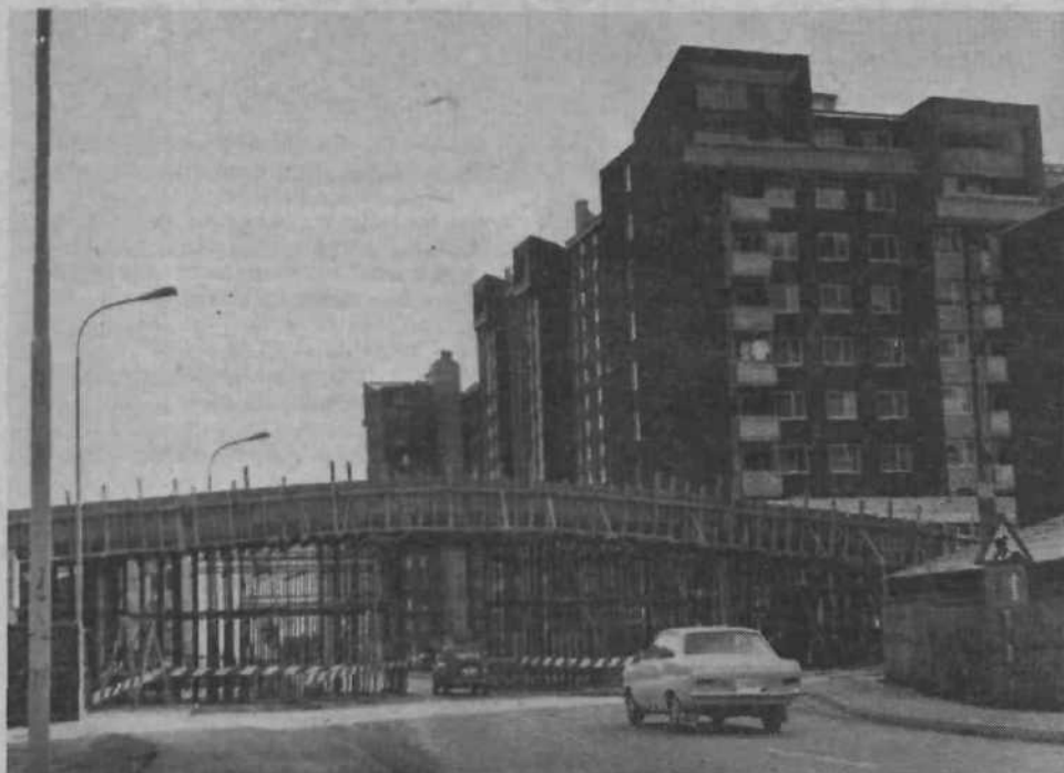
NADHOD ZA PEŠCE – V Soseski 7 gradijo nadhod nad Ulico 7. septembra, ki bo povezoval Glinškovo ploščad in zahodni del Bratovševе ploščadi. Objekt je seveda že dobil ime: pravijo, da je to »most vzdihljajev«.
