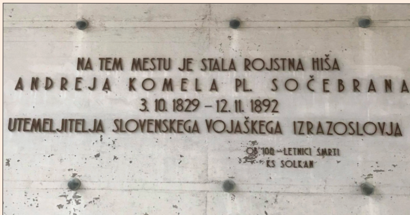
Napis na betonskem nosilcu nadvoza pri solkanskem pokopališču.
