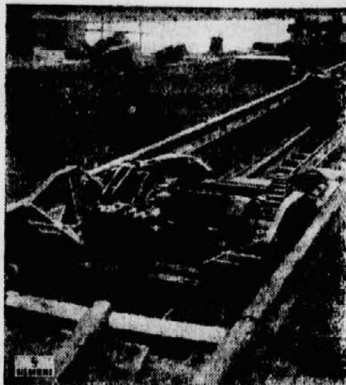
Bild auf eine der beiden Drehscheiben. Im Vordergrund zwischen dem Gleis der Abstoßwagen, im Hintergrund der Bremswagen. Beide in Aufsichtstellung. Zur besseren Erläuterung sind die Schutzhauben der beiden Wagen abgenommen.
