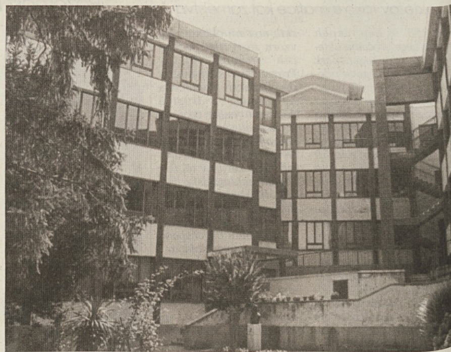
Poslopje trgovskega tehničnega zavoda Žiga Zois (foto Krizmančič)
