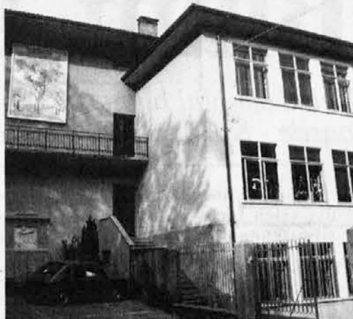
La scuola materna di Clodig prima dei lavori di ristrutturazione conclusi alcuni mesi fa
