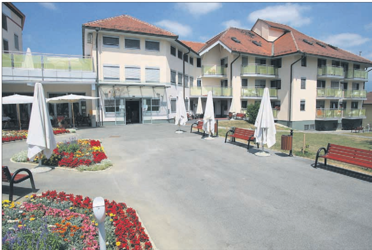
Da je v Lambrechtovem domu poleti prevroče, so Konjičani opozarjali že lani. A kaj, ko so njihovi klimati namenjeni zgolj prezračevanju in pohlajevanju zraka, ne pa hlajenju. Kako bodo oskrbovancem le zagotovili ustreznejše temperature, bo odločal svet zavoda.
