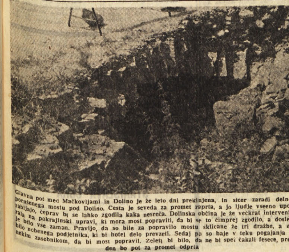
Glavna pot med Mačkovičami in Dolino je že leto dni prekinjena, in sicer zaradi delo porušene mostu pod Dolino. Cesta se seveda za promet zoprtja, a jo ljudje vseno upo-rabljajo, čeprav bi se lahko zgodila kaka nesreča. Dolinska občina je že večkrat interveni-rala na pokrajinski upravi, ki mora most popraviti, da bi se to čimprej zgodilo, a doslej je bilo vse zaman. Pravijo, da so bile za popravilo mostu sklicane že tri dražbe, a ni bilo nobenega podjetnika, ki bi hotel delo prevzeti. Sedaj pa so baje v teku pogajanja z nekim zasebnikom, da bi most popravil. Zeleti bi bilo, da ne bi speč čakali fesece, pre-da bo pot za promet odprta
