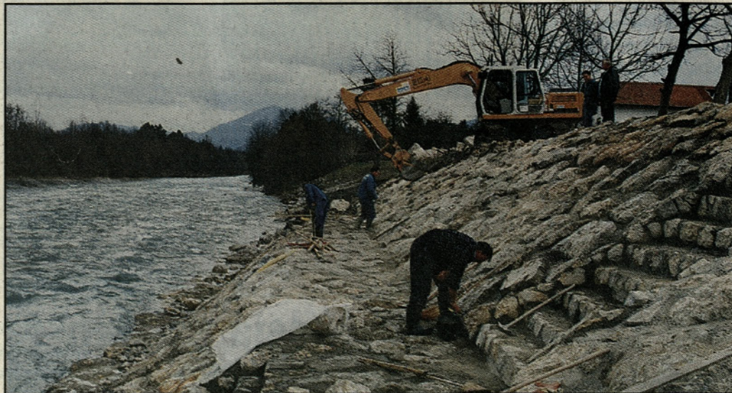
Dela pri zavarovanju desne brežine
