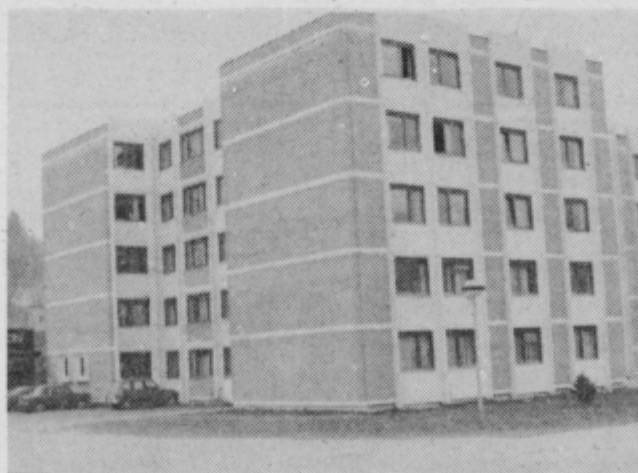
Dom učencev Titovo Velenje, sodobna, moderno opremljena zgradba, ki nudi prostor 720 učencem.
